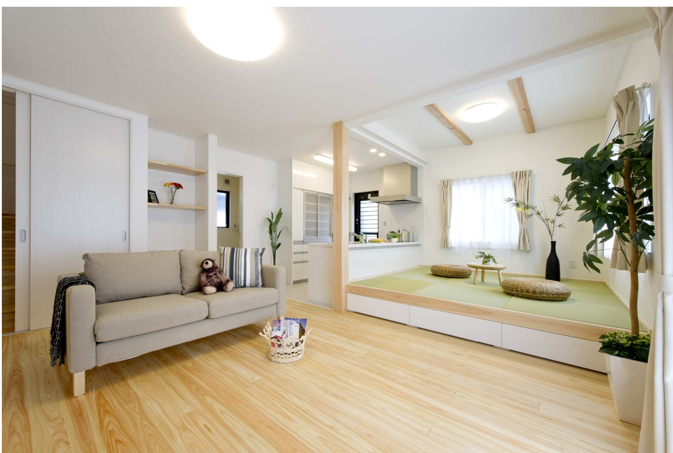
床には無垢の檜を使用。大黒柱や化粧梁を設けた、木の温もりに包まれた健康仕様のリビングスペース。畳コーナーとの段差を利用して、衣服や生活用品を収められる引き出し式の収納を設置。ソファの後ろの引き戸を開けると階段。引き戸の横には棚付きの収納スペースを造り付け
